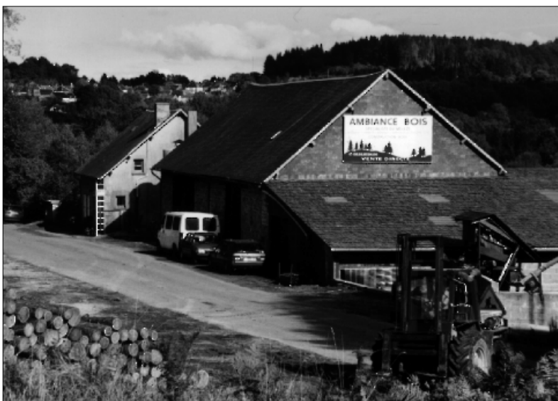
Au bord de la départementale 992, les bâtiments d'Ambiance Bois. Au fond, le village de Faux-la-Montagne
